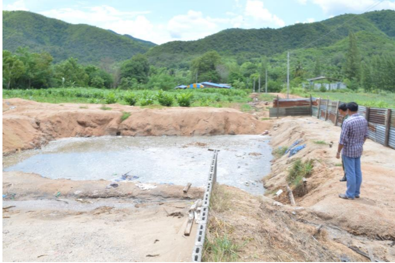
บ่อพักน้ำ ก่อนลงบ่อน้ำเสีย
