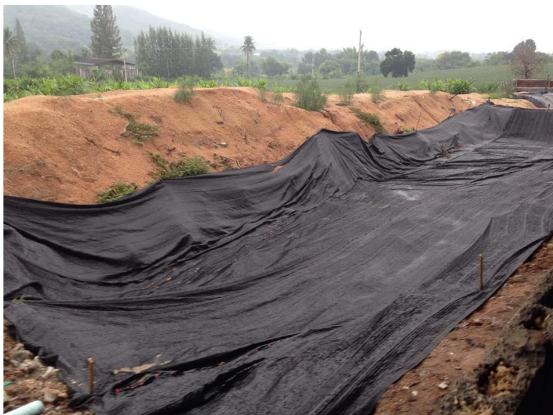
บ่อน้ำเสียบ่อที่ ๒
