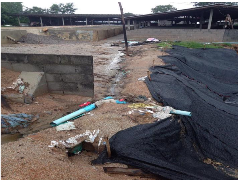
มีท่อระบายน้ำแยกเป็นสองทาง ทางที่ ๑ ปล่อยลงบ่อน้ำเสีย ทางที่ ๒ ปล่อยออกตามร่องน้ำ
