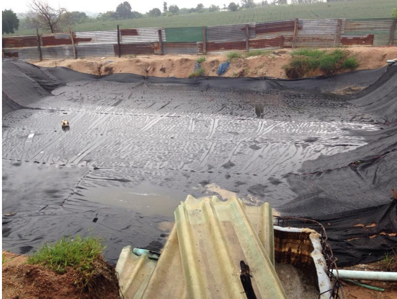
บ่อน้ำเสียบ่อที่ ๑
